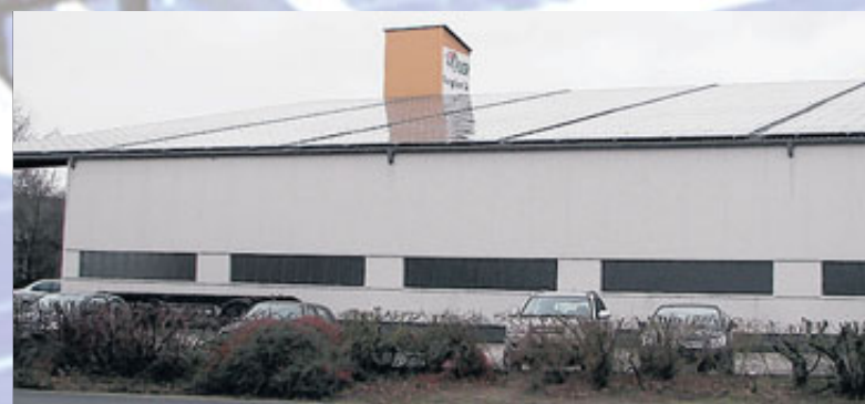
Im Gewerbegebiet Nortmoor liefern die Dächer der Spedition de Boer und des Autohändlers de Jong umweltfreundlichen Strom.
