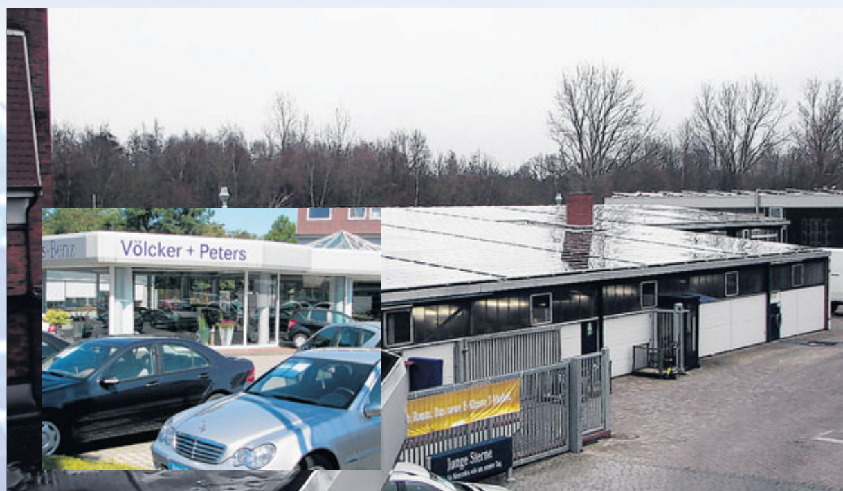
Beim Mercedes-Autohaus Völcker+Peters am Burfehner Weg wurde eine der ersten Photovoltaik-Anlagen von Lichtkraft Nord in Leer installiert. BILD: PRIVAT
