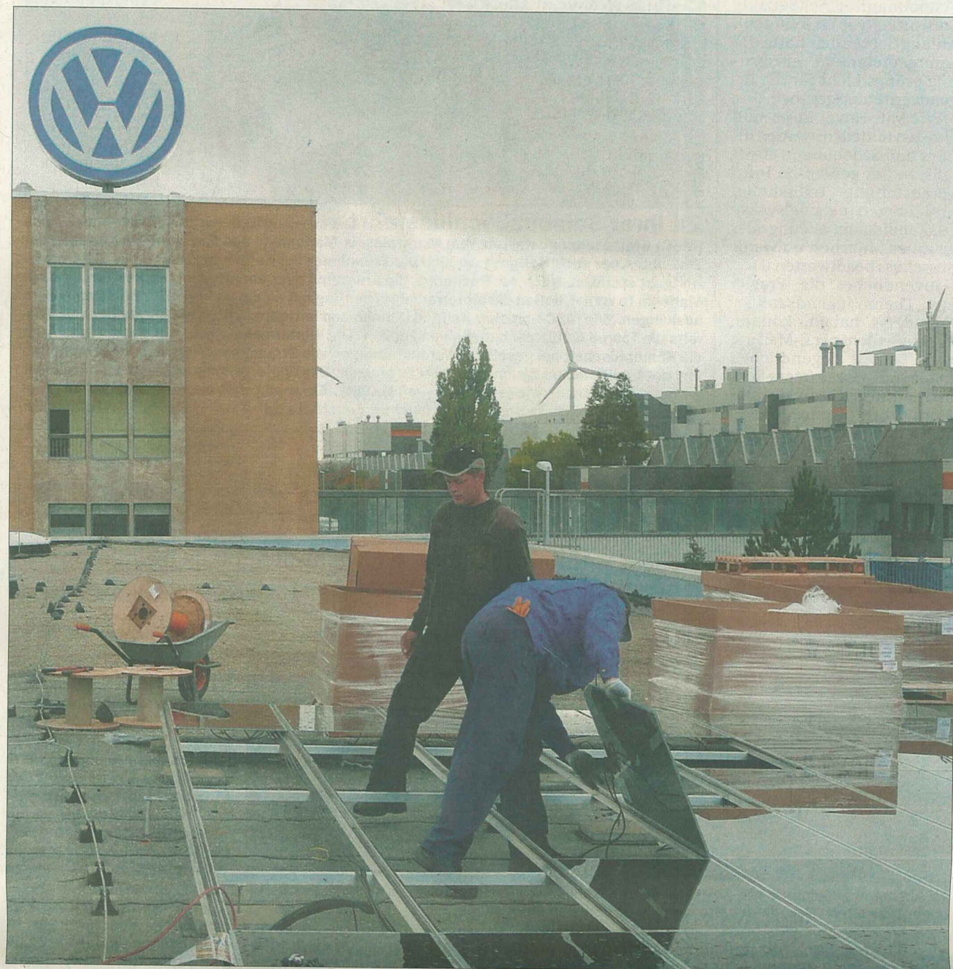
Kräftig geschuftet wird derzeit nicht nur in, sondern auch auf der Halle 1b des Emdener Volkswagenwerkes. Mitarbeiter von Spezialfirmen installieren derzeit die letzten Fotovoltaikmodule auf dem Dach der Halle.
